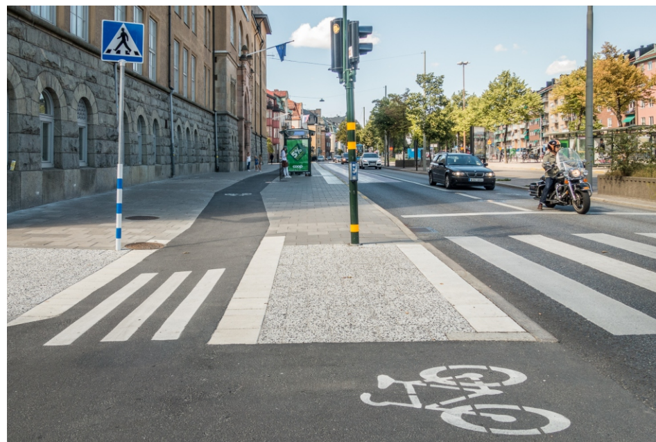
Bild 5: Hållplatsläget på Valhallavägens södra sida efter ombyggnad
