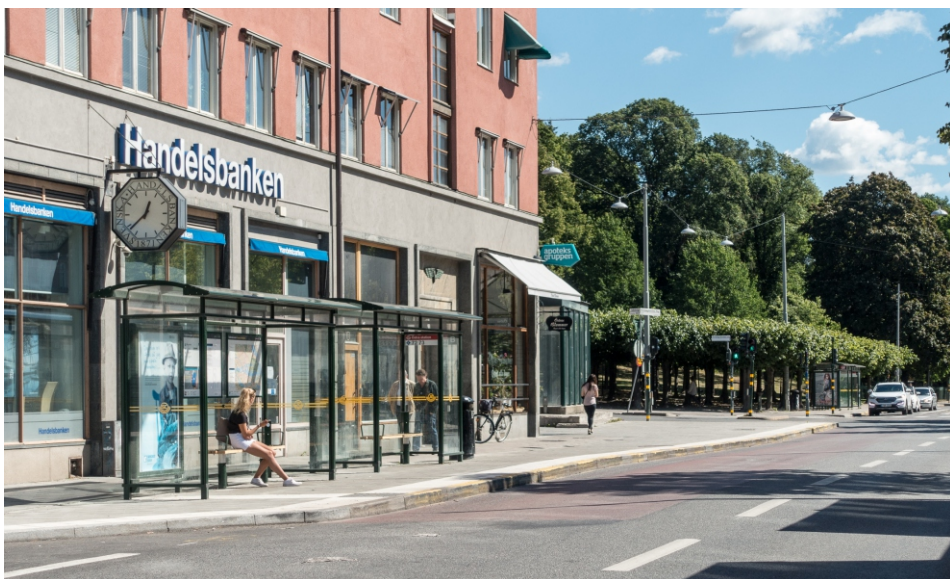
Bild 4: Hållplatsläget efter korsningen med Drottning Kristinas väg efter ombyggnad
