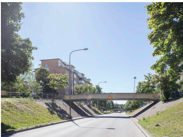
Rinkebystråket före och efter ombyggnationen
