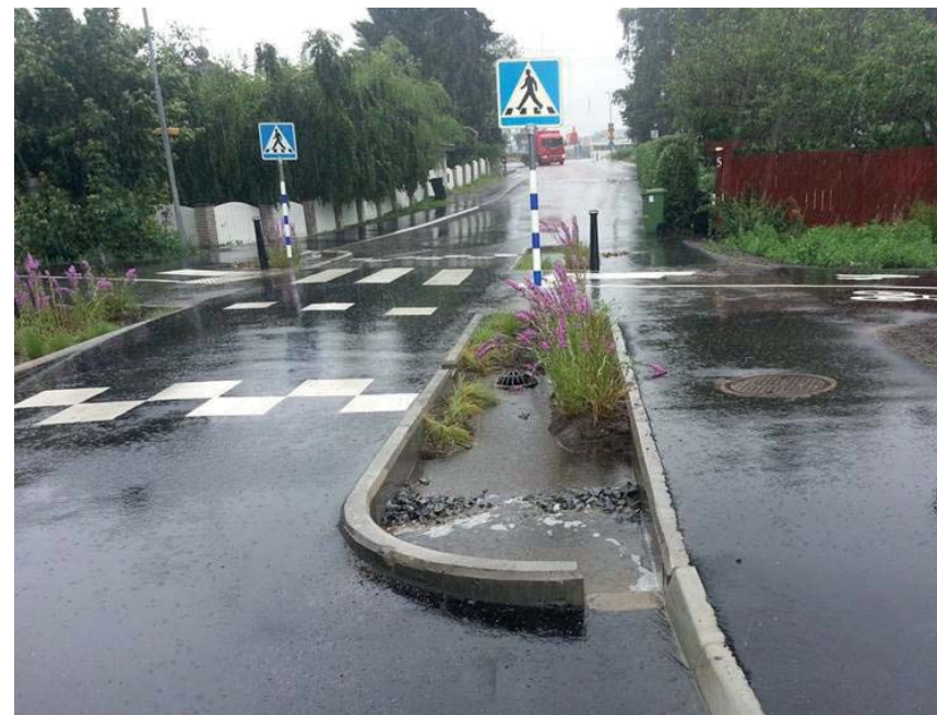
Bra exempel på vålfungerade raingarden för lokalt omhändertagande av dagvatten i vägmiljö, Öringevägen i Tyresö.
