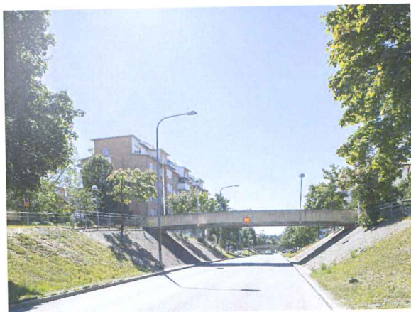
Rinkebystråket före och efter ombyggnationen
