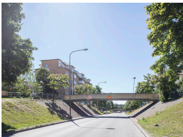
Rinkebystråket före och efter ombyggnationen
