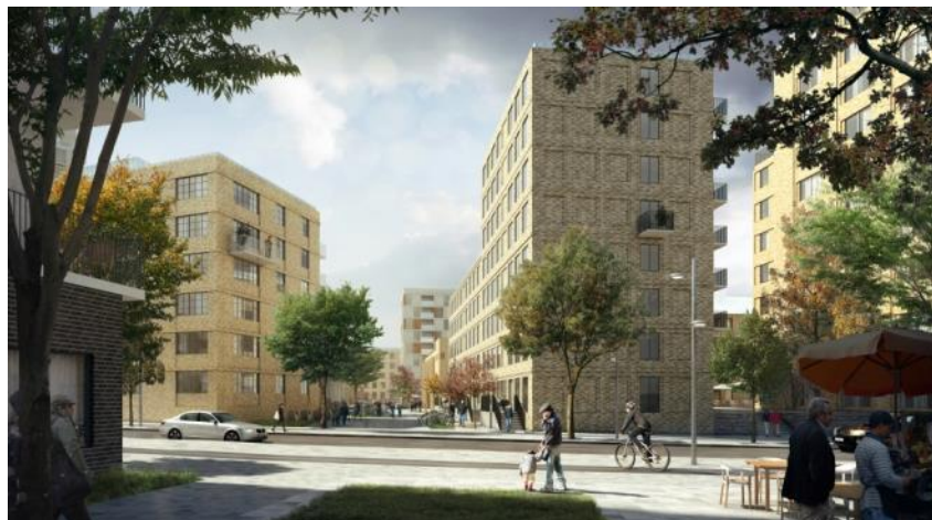
Vy från norr med gångfartsgatan mellan kvarter B och C. (AIX Arkitekter) Variation i höjd och släpp mellan byggnaderna skapar goda ljusförhållanden på gård och gata.
