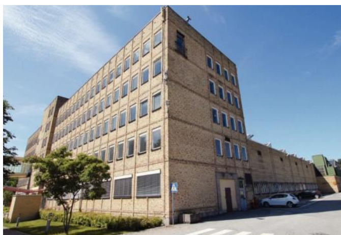
Kontorsbyggnaden. Byggnadernas rationella och enhetliga gestaltning speglar deras ursprungliga verksamhet. Den lägre fabriksdelen, som ligger både inom detaljplanen etapp 1 och 3, rivs.
