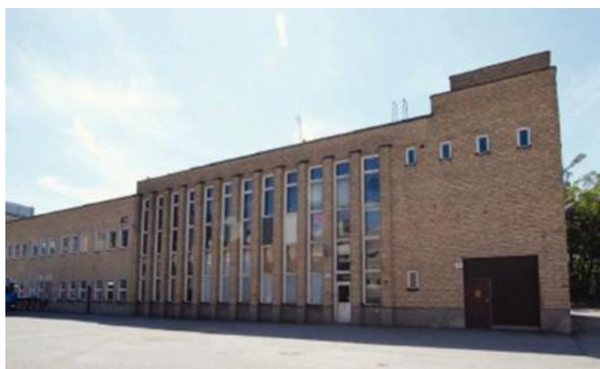
Kraft- och värmecentralen. Fasad med murade pilastrar.
