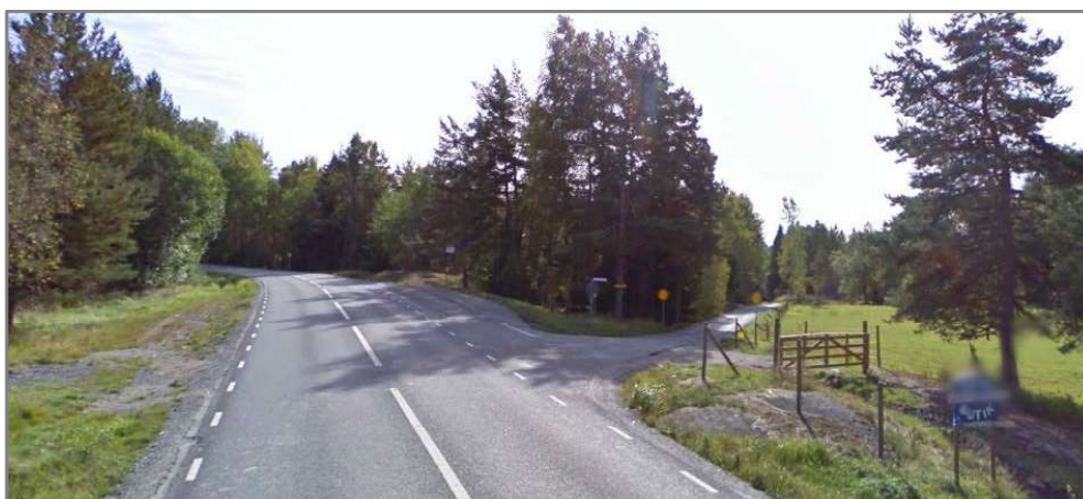
Figur 3-22 Vy från öster över Tavastbodavägens anslutning till Stavsnäsvägen, busshållplatsen rekommenderas att placeras före korsningen för att förbättra sikten från öster
