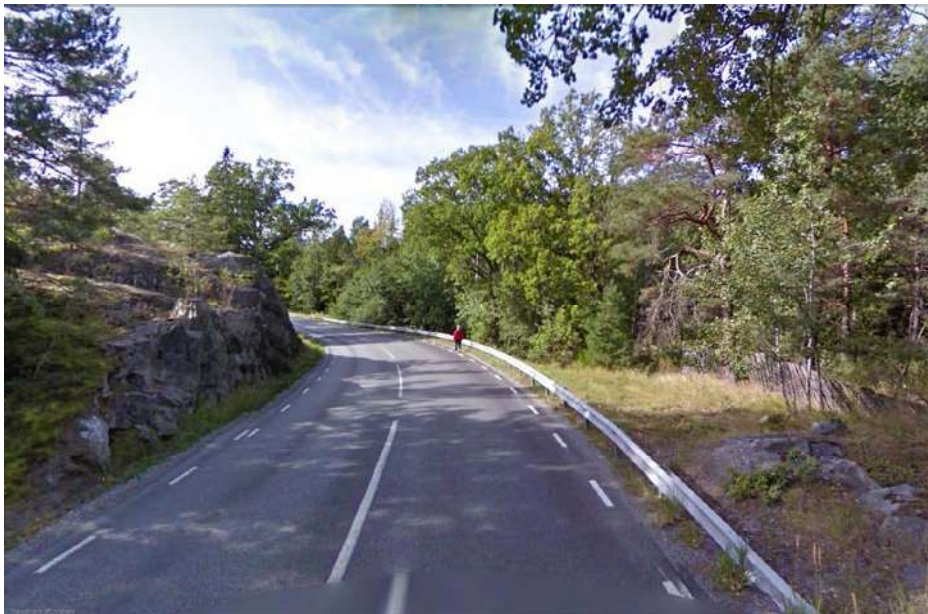
Figur 2-1. Exempel på avsnitt med begränsad sikt där oskyddad trafikant befinner sig i vägbanan, vid Hamnvägen väster om Stavsnäs. Källa: maps.google.com
