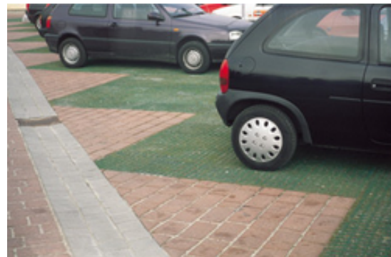
Figur 14 Parkering med gräsarmering.
