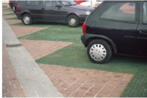
Figur 14 Parkering med gräsarmering.
