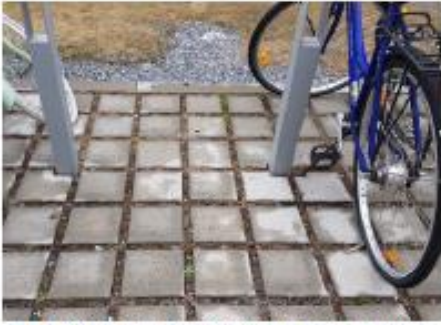
Figur 13 Genomsläppliga fogar mellan gatsten samt fördröjd avrinning via makadam.
