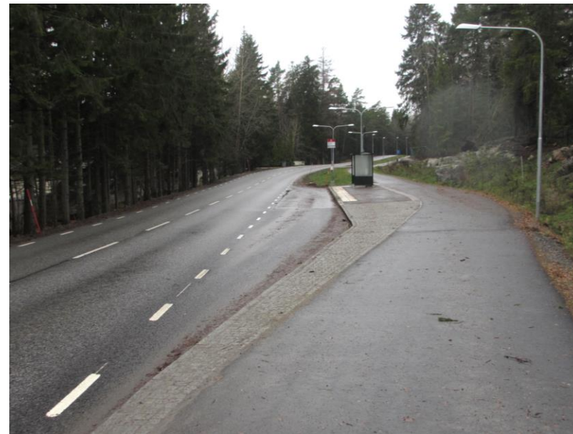
Hållplatsen mot Slussen
