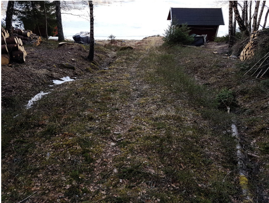
Figur 7 Diken ned till norra stranden. På platsen har även skog avverkats illegalt inom strandskyddsområdet.
