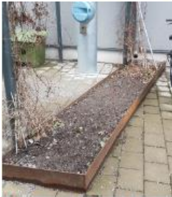
Figur 18 Takvatten till växtbädd.
