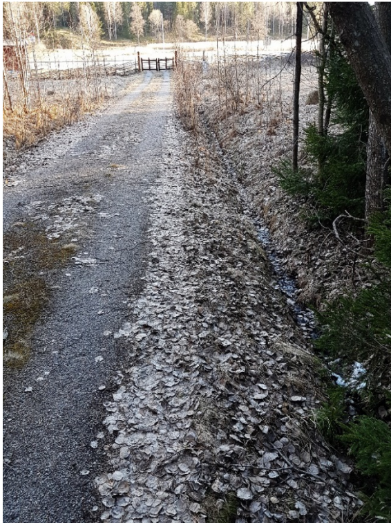
Figur 9. Dike länge med uppfart.
