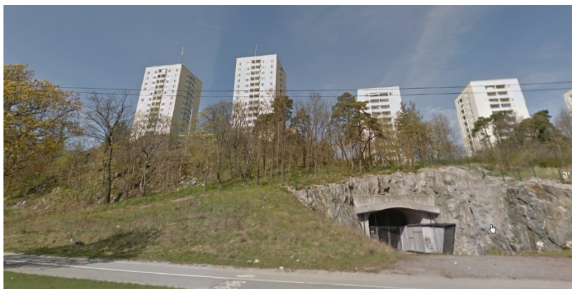
Naturen vid planerat läge för tunnelmynning vid Liljeholmen består av en bergssluttning med berg i dagen och med yngre lövträd. På platsen finns redan i dag en tunnelmynning som leder ned till berggaraget som hör till Liljeholmens centrum.
