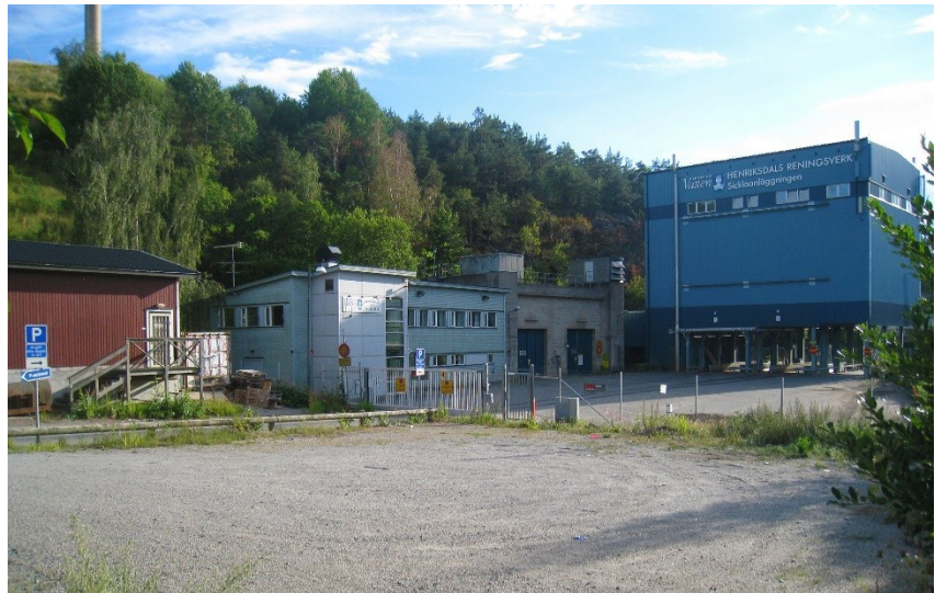
Befintlig anläggning. Foto taget från norr (Sweco 2016-08-25).
