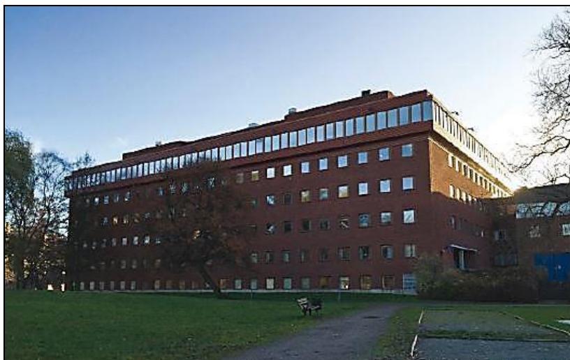
Atriumhuset sett från väster. Bild: Nyréns Arkitektkontor
