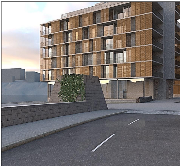
Vy över pumpstationen från den nya lokalgatan. De yttersta väggarna följer murens vinkel som motsvarar en lutning på ca 75 grader. Bild: Sweco
