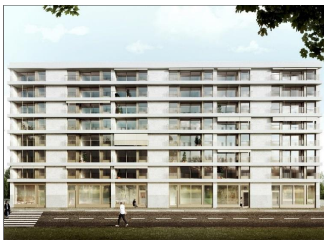
Hus 3 sett från Primusgatan. Bild: Jägnefält Milton
