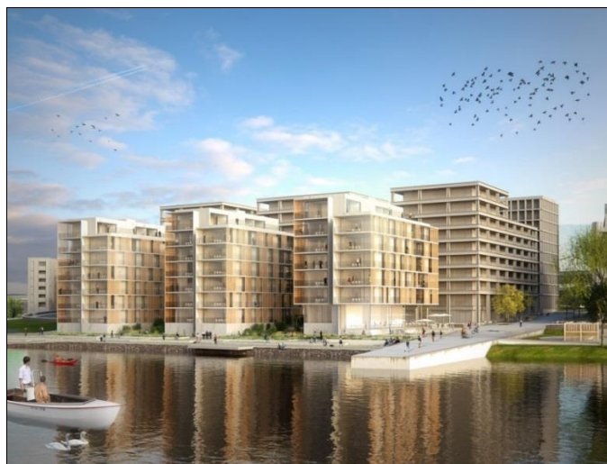
Vy över hus 12, 13, och 14 från vattnet. Bild: Arkitema Architects AB
