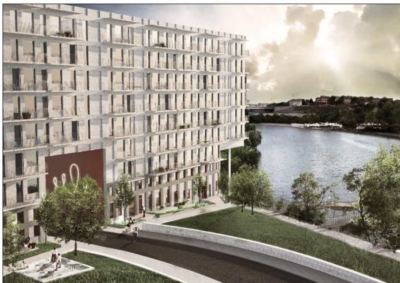
Hus 1, fasad mot nordväst. Bild: Vargarkitekter
