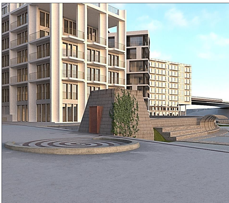
Vy över pumpstationens entré från huvudstråket. Bild: Sweco
