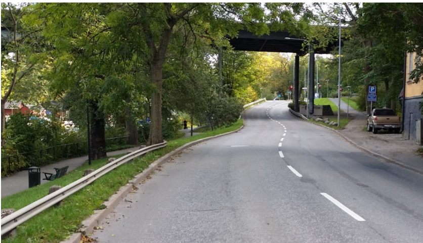
Figur 3. Bild på körbanan under Västerbron, riktning österut.
