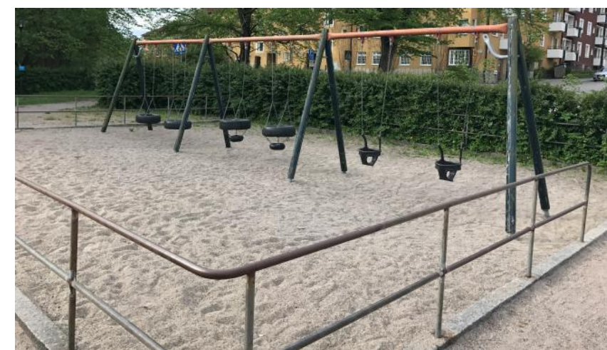
Inspringningsskydd och kantsten behålls, ny öppning i staketet tas upp. Lekutrustning byts ut.
