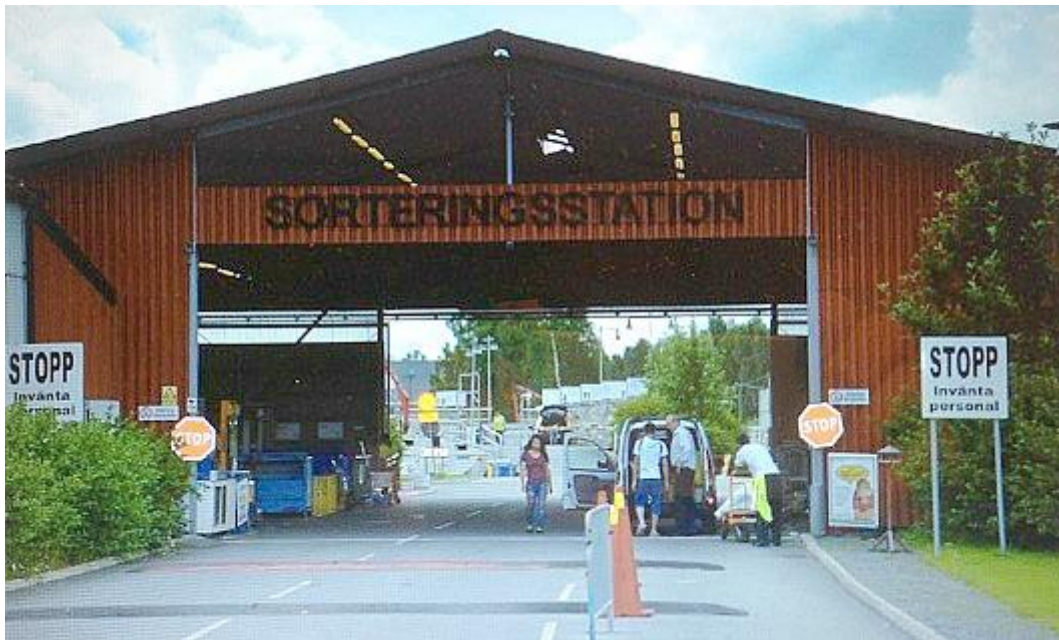
Fig 20. Kretsloppsparken Alelyckan, Göteborg, mottagningshallen Referens: www.mittsundbyberg.se
