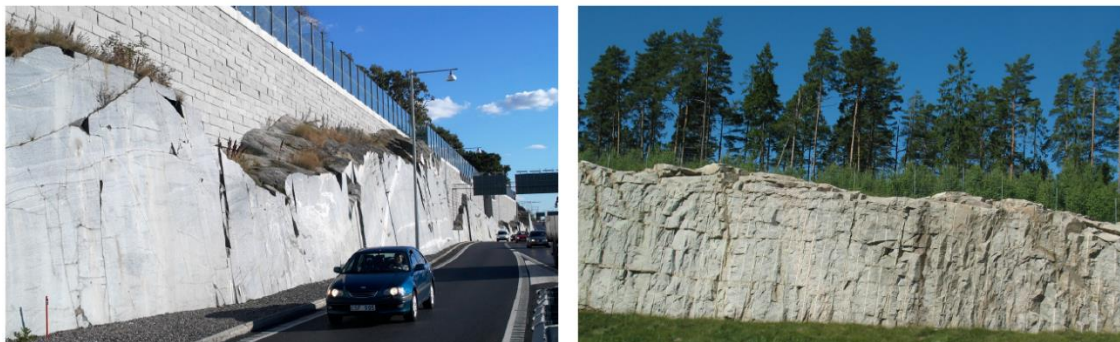
Fig. 28 Medveten släntning eftersträvas i området. I den vänstra bilden syns ett exempel på vajersågning och i den högra ett exempel på sprängning med tätsöm. (Källa: Trafikverket)
