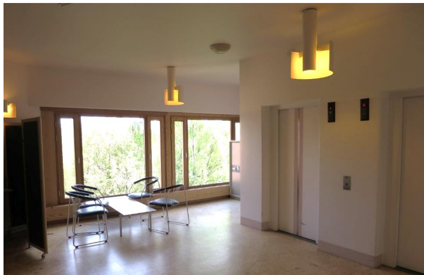
Del av hisshal. Exempel på målad furu i glaspartier, dörrar, undertakslister, fönster, fönsterpaneler, foder och lister. Takarmaturerna är specialritade av Bengt Lindroos och Nyréns. Bild Tyréns.
