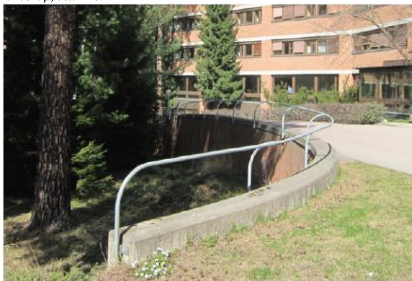
Terrasserande betong/tegelmur med räcke till huvudentré. Rosa tegel på fasad i bakgrunden.
