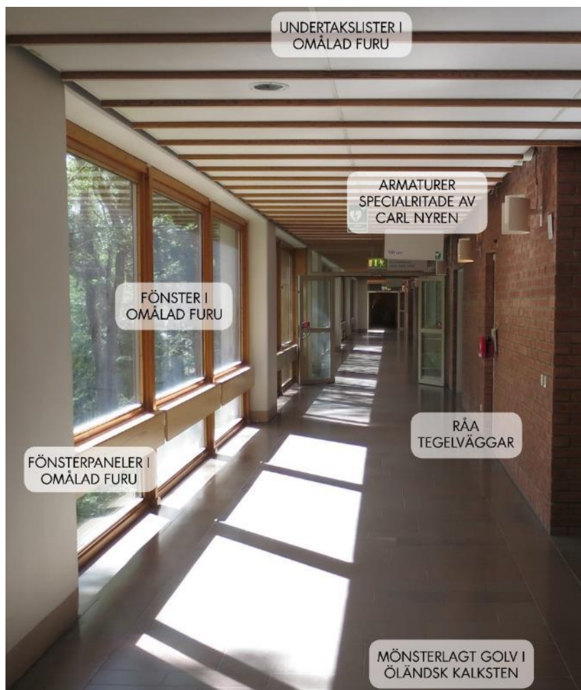
Kulturhistoriskt värdefulla detaljer i den glasade huvudkorridoren i bottenplanet på "Ormen långa". Bild: Tyréns. Exteriör (se bilder nedan)
