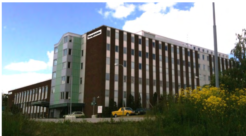
Vinstagårdsskolan, vy från tillfarten i sydost. Parkering är på byggnadens östra sida.
