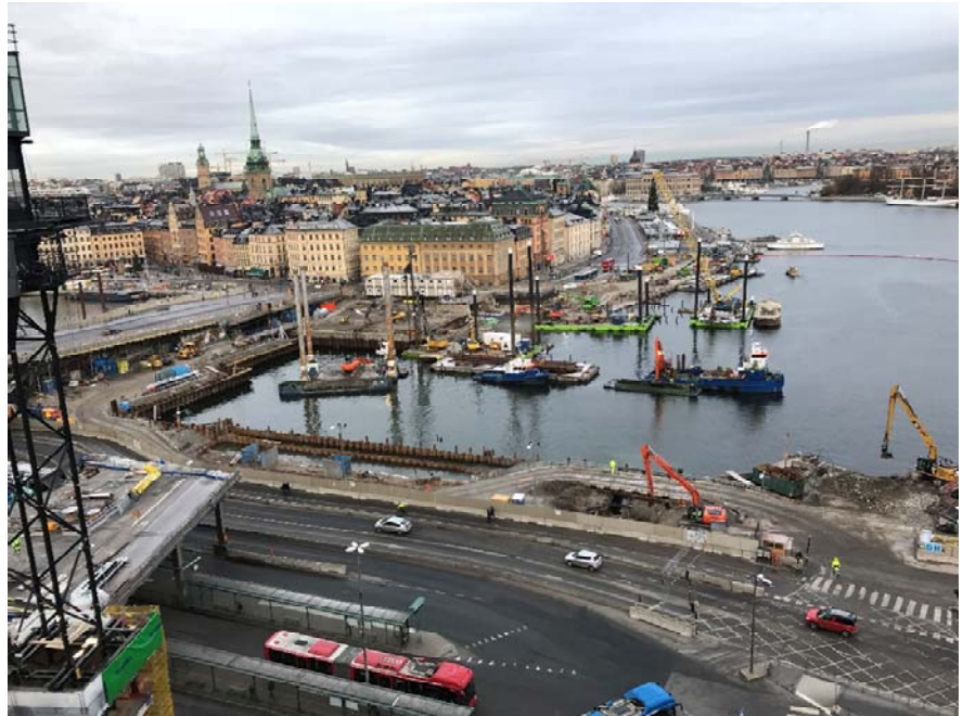
Figur 6. Arbeten med renovering av Slussen foto Miljöförvaltningen, Stefan Troëng
