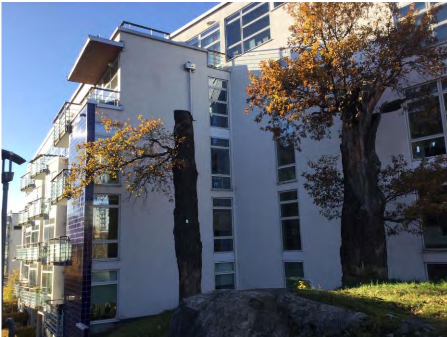
Figur 21. Inom tätbebyggda områden lämnas ibland jätteekarna kvar men är så pass nära husfasader att de påverkas negativt av beskuggningen, behöver beskäras och hotas att tas ned helt om de bedöms utgöra en säkerhetsrisk på grund av nedfallande grenar.
