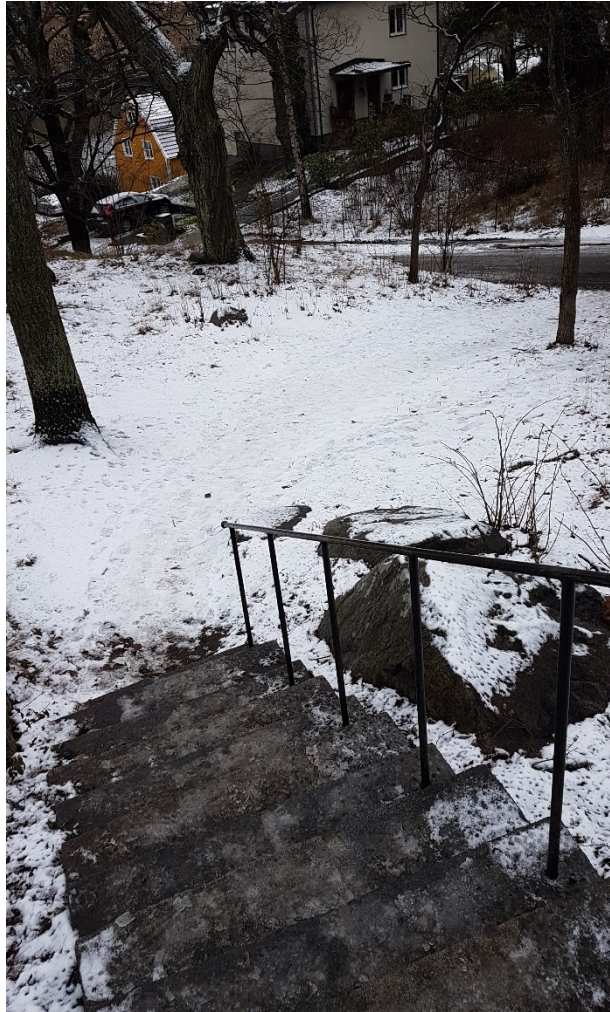
Bild på befintlig trappa ner mot Essingeringen.
