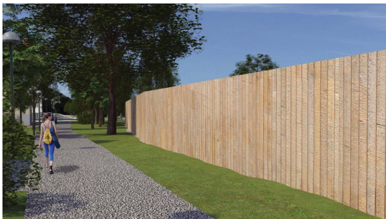
Bullerskärm höjd 6 m ovan bollplan (svart linje) med takkrön över gradänger. Ekvivalent A-vägd bullernivå för en fotbollsmatch.
