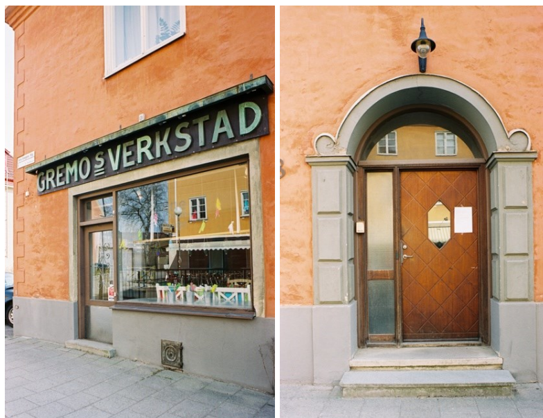
T.v. Lokal i bottenvåningen mot Stora Gungans väg. T.h. En av portarna till byggnaden (bilder från Bebyggelseregistret).
