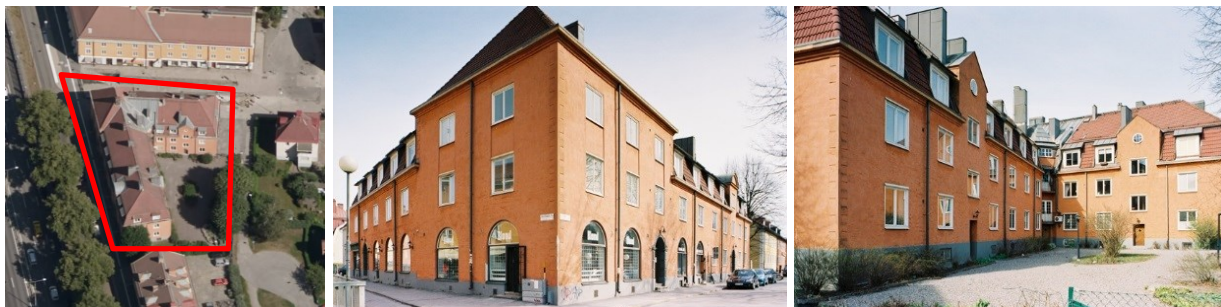
Från höger: Flyfoto från 2016 över aktuell fastighet. Huset från gatuhörnet mot Nynäsvägen och Stora Gungans väg (bild från Bebyggelseregistret). Huset från innergården (bild från Bebyggelseregistret).
