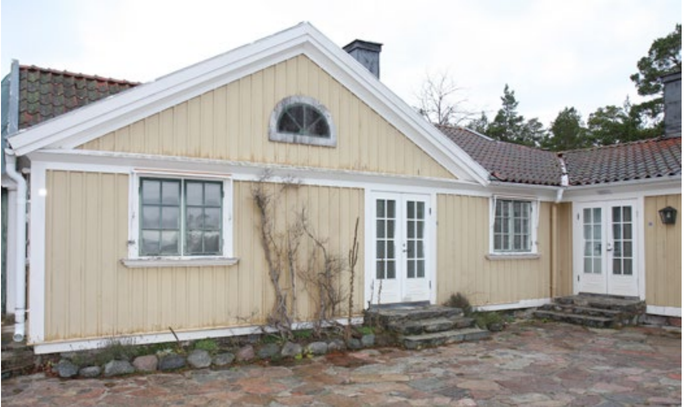
Huvudbyggnaden, fönster/fönsterdörrar mot havet.
