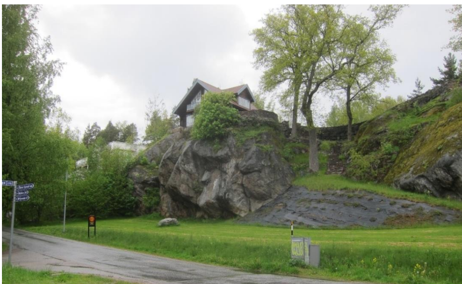
Bergsformationen i sydväst mot Långsjövägen med flera värdefulla ekar. En naturstenstrappa tar sig ner mellan ekarna. En gångstig/ny trappa skulle kunna snedda ner längs den lägre slänten som på bilden syns plastövertäckt mot ogräs.
