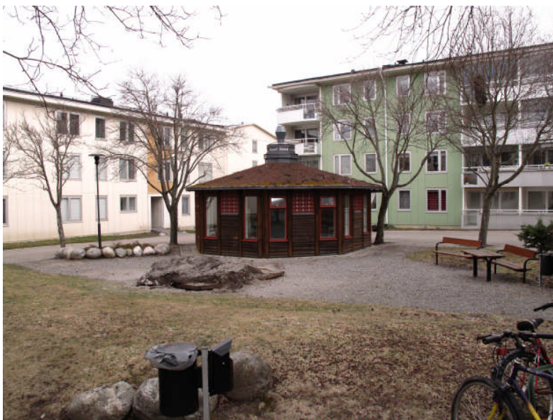
Befintlig bebyggelse, tvättstuga.
