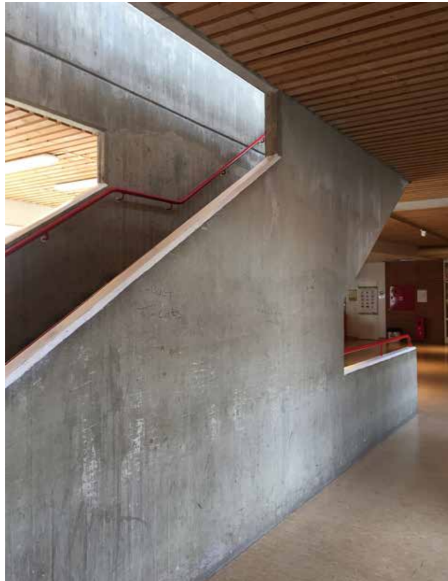
Skulpturala trapphus i platsgjuten betong. Gymnasiet.
