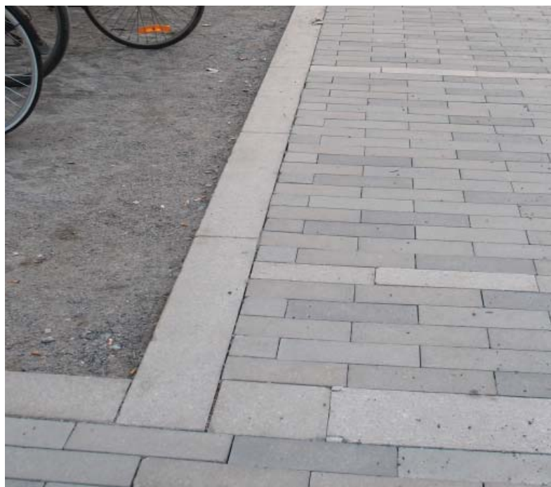
Referens betongsten med granitfris
