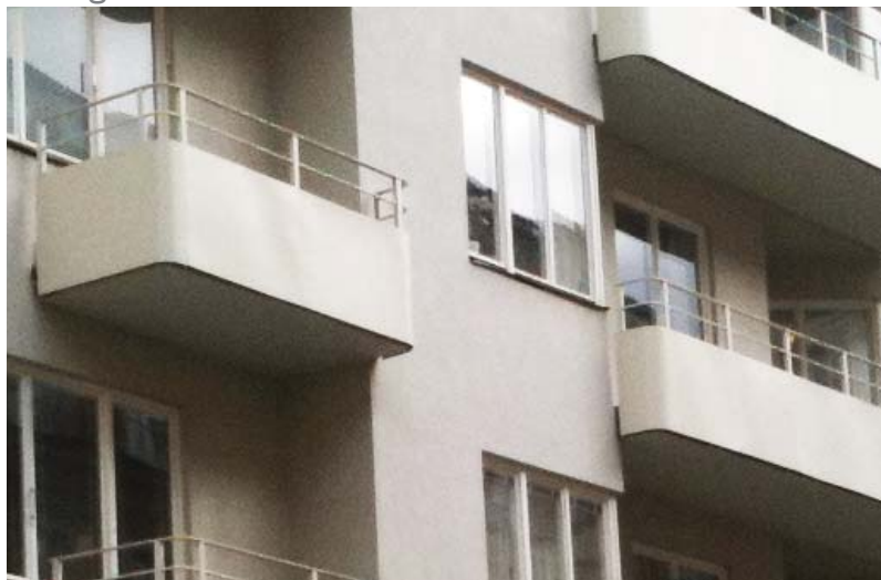
Referens på balkonger med överliggare vid burspråk
