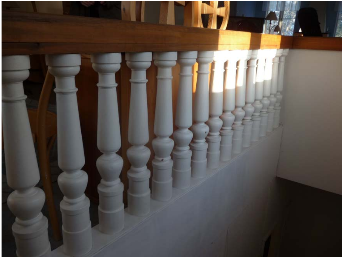
Balusterräcke vid trappa till läktarvåning/ungdomsavdelning
