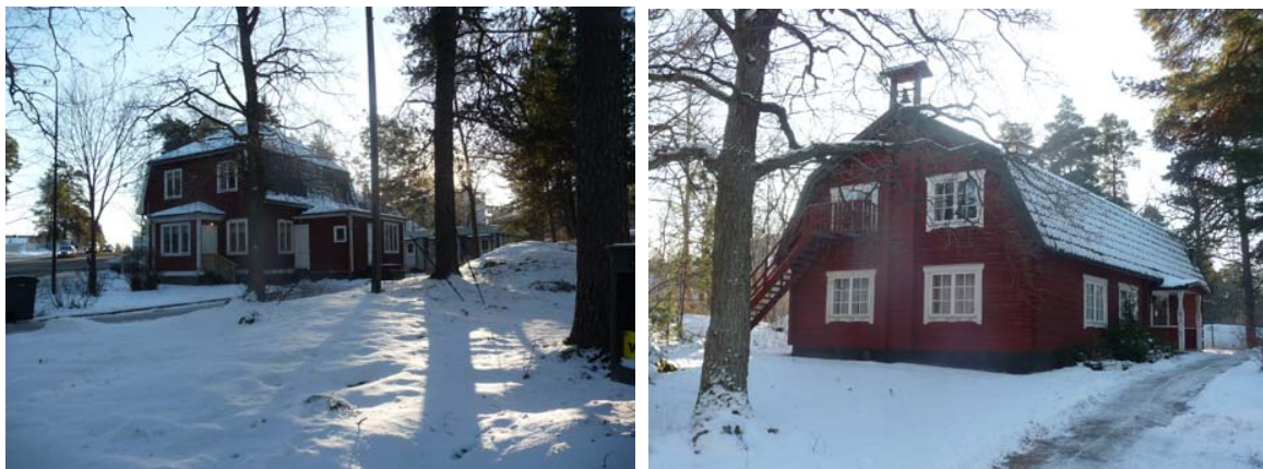
AA-huset, friliggande villa intill Tallåskyrkan samt SMU-gården bidrar till det småskaliga och miljöskapande värde upplevelsevärdet av byggnader kopplade till brukssamhället Gustavsberg. Från förra sekelskiftet.
