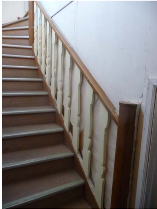
Trappa till f.d. läktare, ungdomsavdelningen
