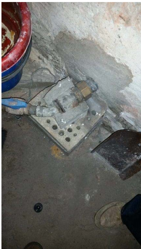
Bild 18. Fastighetens försörjning av vatten: inkommande ledning för kallvatten.
