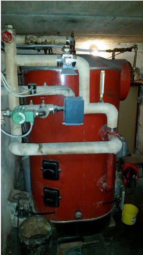
Bild 13. Oljepanna. Märkt med tillverkningsår 1966.
