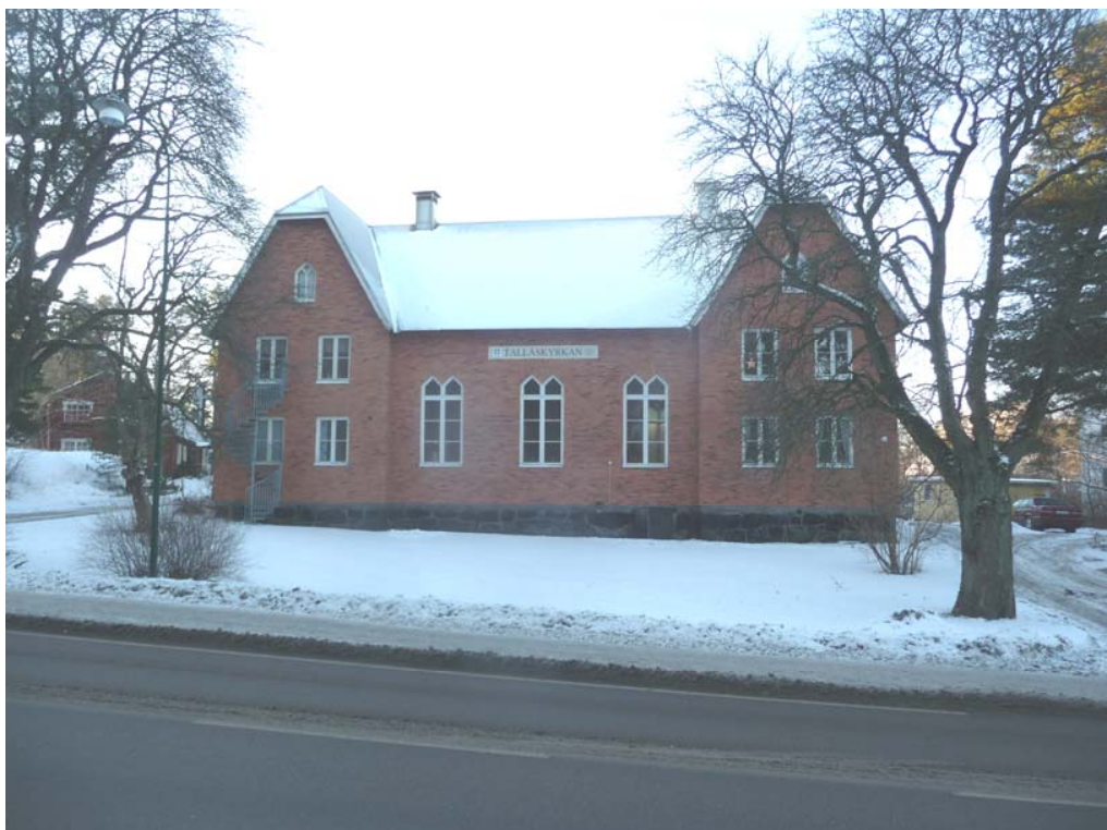
Tallåskyrkans fasad mot Skärgårdsvägen. Det centriskt placerade tornet är avlägsnat och ersatt av en tillkommande ventilationsskorsten.
