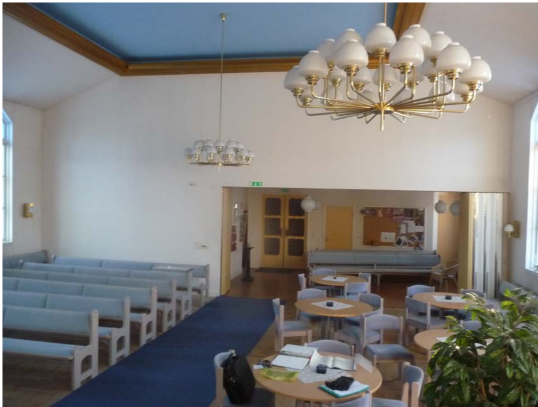
Vy mot den tidigare läktaren som byggdes igen och inreddes till ungdomslokal 1959. Ursprungligen hade kyrksalen ett högt tak med ventilationsmöjlighet/utvädring, genom ett centralt placerat mittorn. Utformningen framgår av en ritning från 1939 signerad Olof Thunström.
