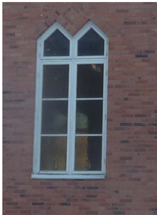
Fotot visar förändringsutseendet för samma fönsterparti- del av fasad mot Skärgårdsvägen. Foto före 1959 samt efter ombyggnad med fasadtegelbeklädning. Förändringen innebar avlägsnande av foder och omfattningar med listverk runt fönster. Utbyte av fönster. Nytt fönsteruttryck med två spetsar och ny fönsterluftindelnings. Den lätta eleganta träbyggnaden med snickeridetaljer har förvandlats till ett "stenhus".
