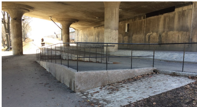
Figur 8. En ny ramp mot Rålambshovsparken.
