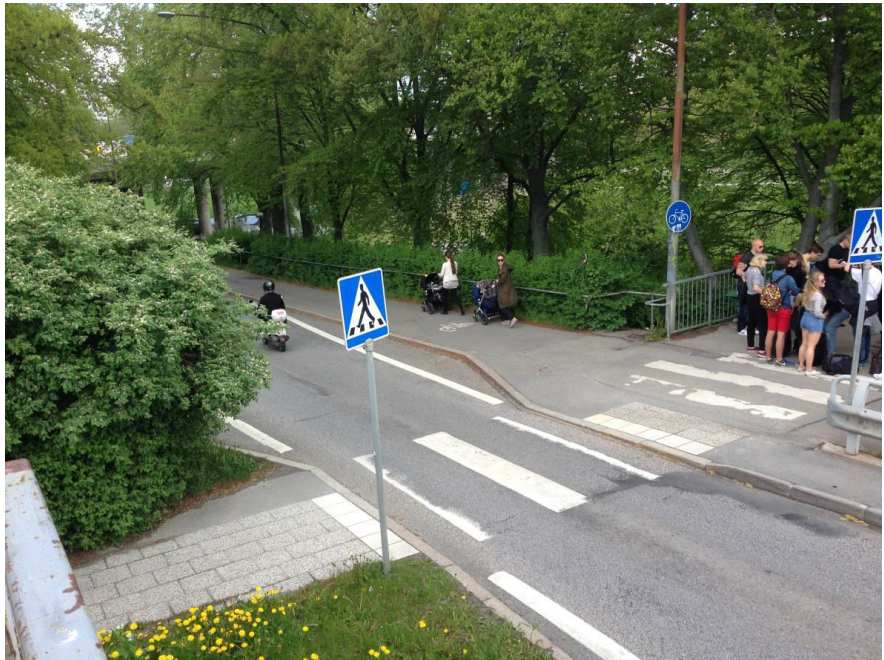
Figur 4. Vy över det norra övergångsstället före ombyggnaden
