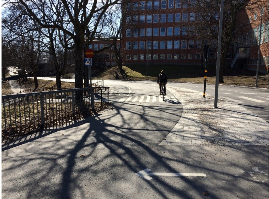
Figur 10. Vy över cykelbanan vid Görwellsгатan efter ombyggnaden
