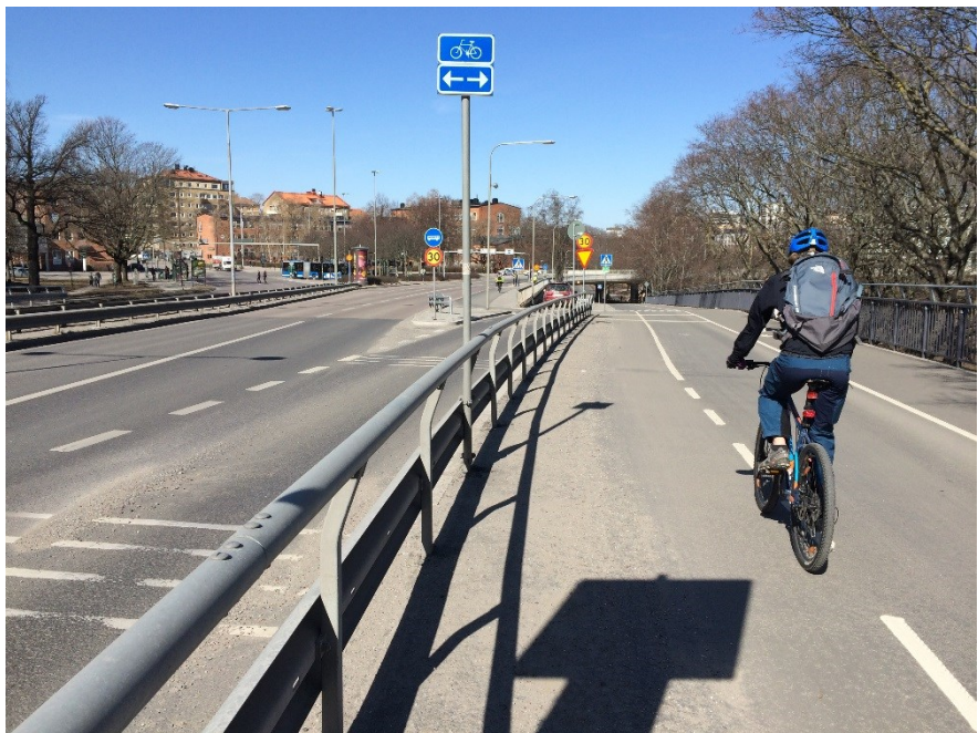
Figur 3. Vy över det södra övergångsstället söderifrån, efter ombyggnaden.
