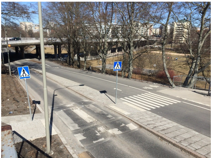
Figur 5. Vy över det norra övergångsstället efter ombyggnaden
