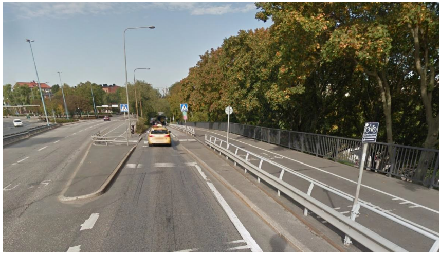
Figur 2. Vy över det södra övergångsstället söderifrån, före ombyggnaden. Övergångsstället saknar hastighetssäkring
