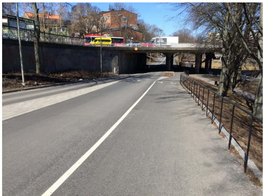
Figur 7. Vy över cykelbanan i riktning mot Lilla Västerbron efter ombyggnaden
