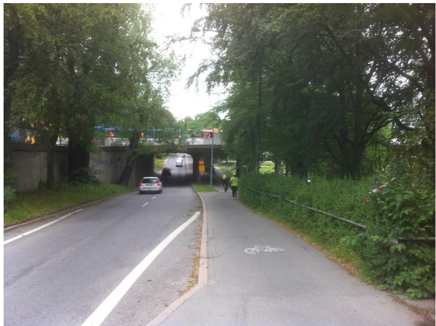
Figur 6. Vy över cykelbanan i riktning mot Lilla Västerbron före ombyggnaden
