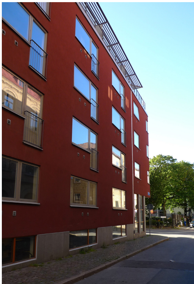
Exempelbild: fasad i färgad puts med avvikande material i sockel
