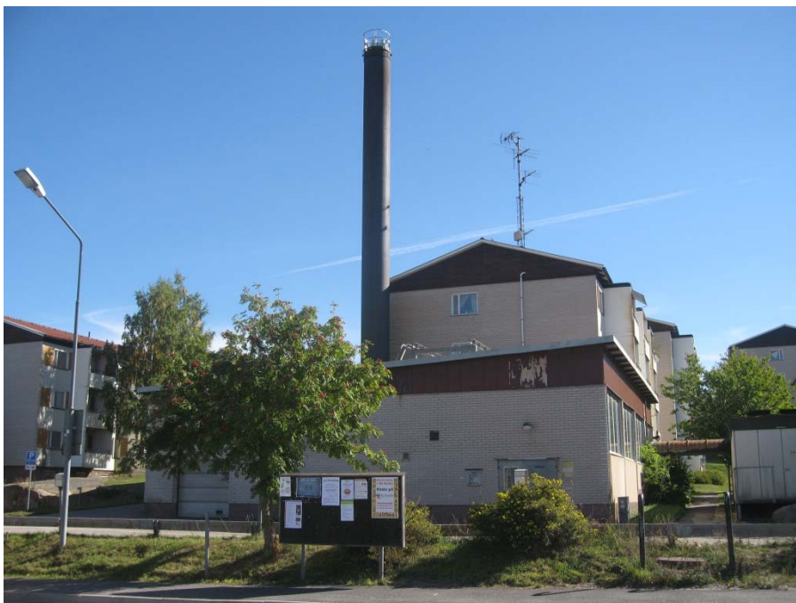
Figur 48. Panncentralen längs Skyttevägen i Munkmora
