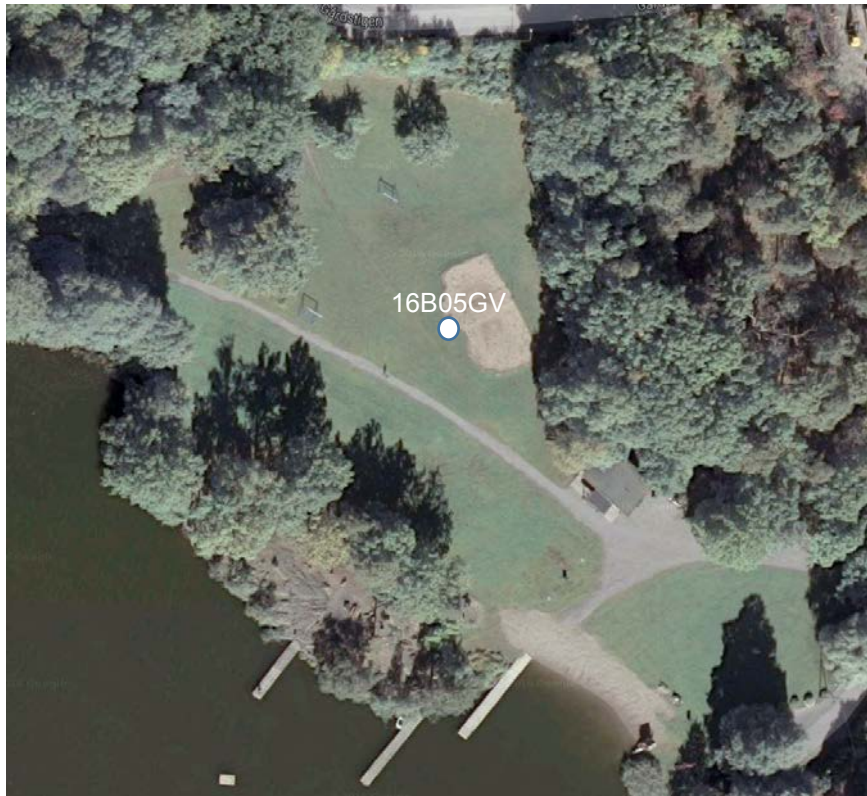
Figur 8.2: Grundvattenrör som installerades i samband med den aktuella undersökningen vid Långsjön.
