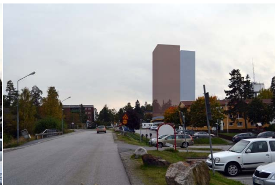
Figur 29. Efter: Från Skyttevägen söderut mot Markörplan, med en ny byggnadsvolym enligt vad det alternativa planförslaget medger. (Fotomontage: Värmdö kommun.)
