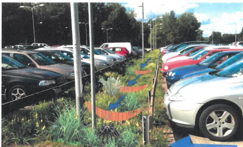
Figur 4 exempel på nedsänkt växtbädd som avvattnar parkering.
