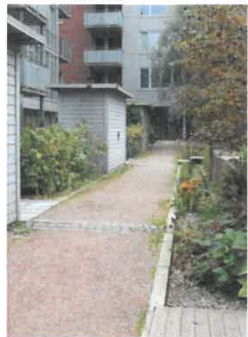
Figur 9 Exempel på permeabla beläggningar i Berlin, Stockholm och Oslo.
