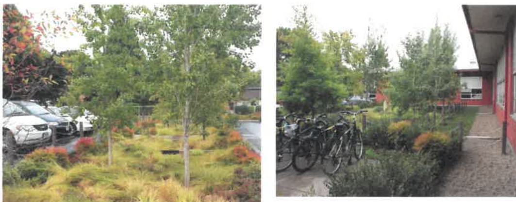
Figur 7 Exempel på utformning av regngårdar vid en grundskola. Avvattnings sker från omgivande parkeringsytor och tak.
