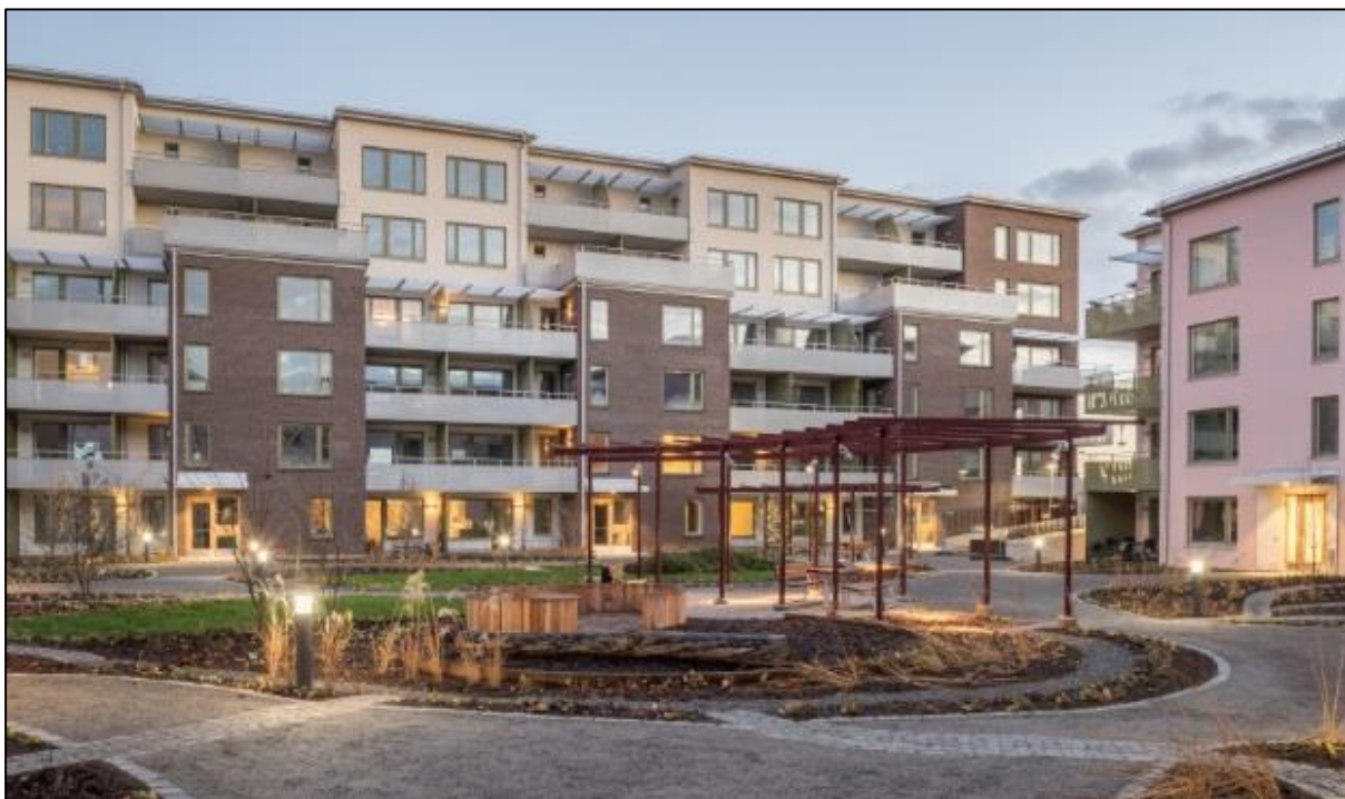
Figur 5-1. Avledning av takvatten till planteringar via ränndalar anlagda i gatsten. Exempelbild från Linnéhuset i Uppsala (Källa: Uppsalahem).
