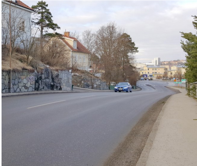
Figur 2. Essingeringen i riktning mot korsningen med Badstrandsvägen
