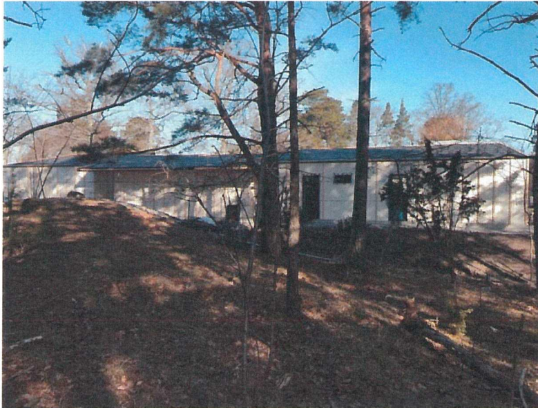
Bild 3: Fasad mot Söder
