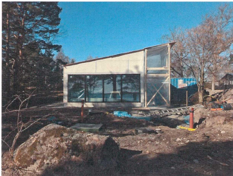
Bild 2: Fasad mot Öster
