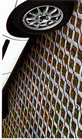
Gräsmererad plattytta anläggs på delar av parkeringsplatsen.
