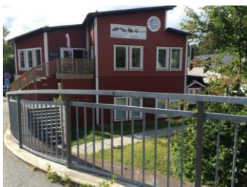
Figur 42 Affär med nedanförliggande trädgård och restaurang
