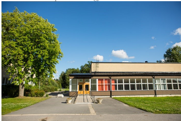
Bild 4. Matsalen på Bromma gymnasium.
