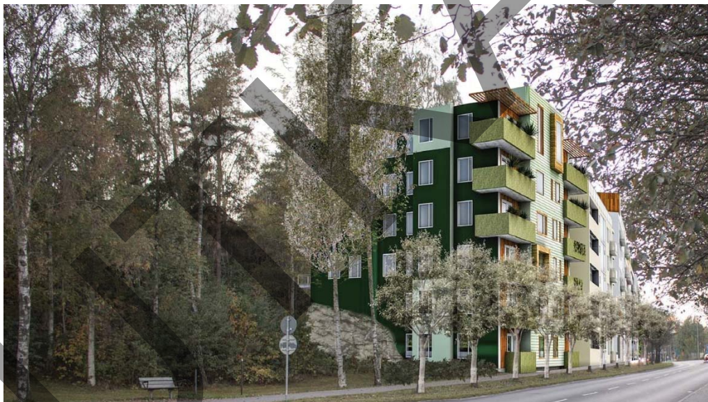
Vy längs Bollmoravägen mot väster. Bostadshus i souterräng. Bild Reierstam arkitektur
