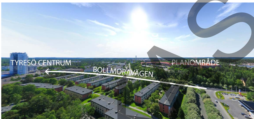
Vy mot sydöst över Bollmoravägens sträckning mellan planområdet och Tyresö centrum.
