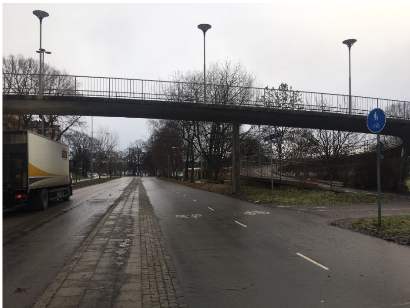
Figur 8. Bild över cykelbanan utmed Rålambshovsleden efter ombyggnationen
