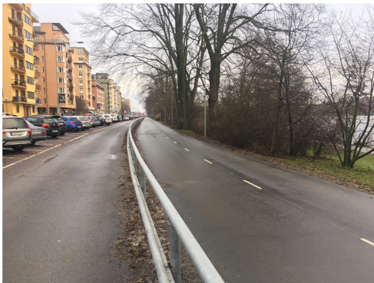
Figur 3. Bild över cykelbanan på Norr Mälarstrand efter ombyggnationen
