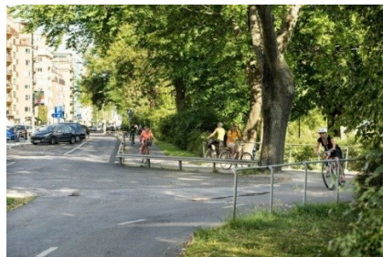
Figur 5 och 6. Bild över cykelvägen på Norr Mälärstrand och vid vändplanen, som visar en kraftig sidoförskjutning innan ombyggnationen och skiss som visar cykelbanans nya sträckning efter ombyggnationen.
