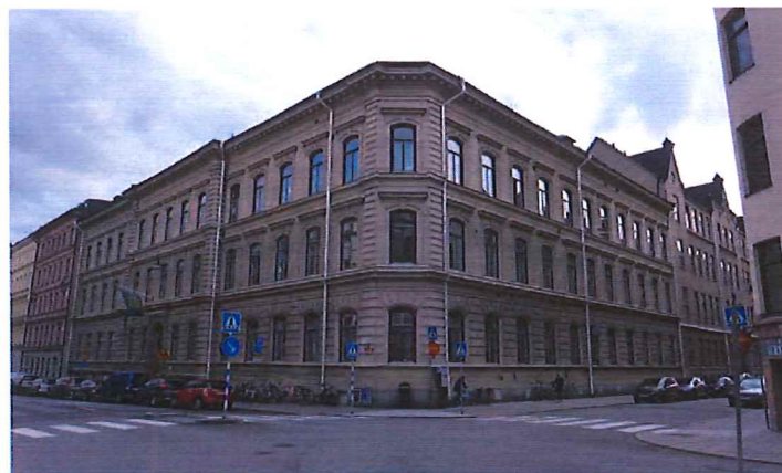
Skolan sedd från norr. Anläggningen inordnar sig i den omgivande stenstadsarkitekturen men särskiljer sig genom sina stora fönsteröppningar och tilltagna våningshöjder.
