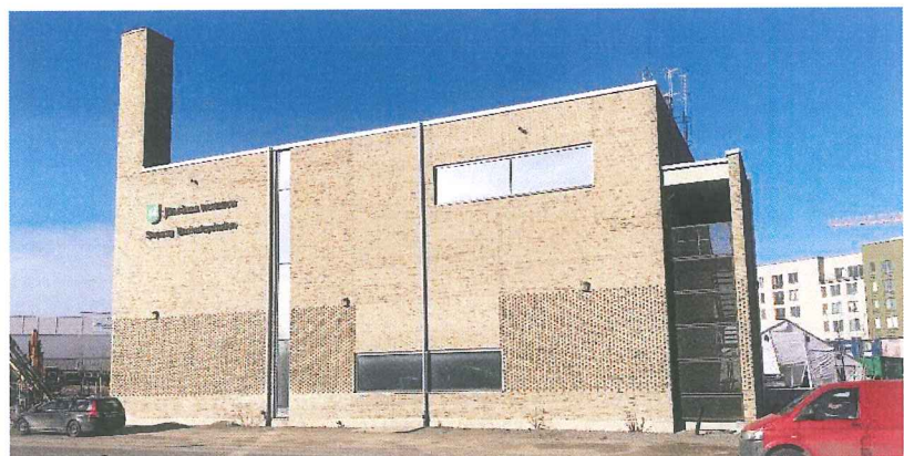
Sopsugsanläggning med god gestaltning (Barkabystaden).
