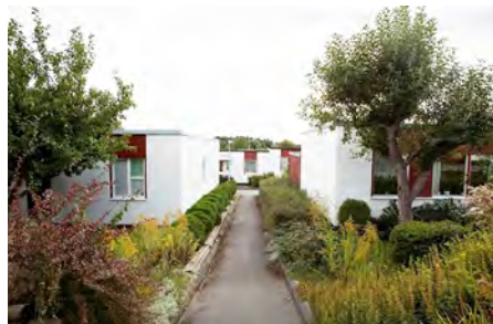
2. Grönklassad bebyggelse i Tensta mot Spångadalen.
