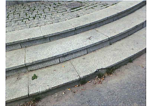
Trasiga trappsteg av granit ersätts med nya.
