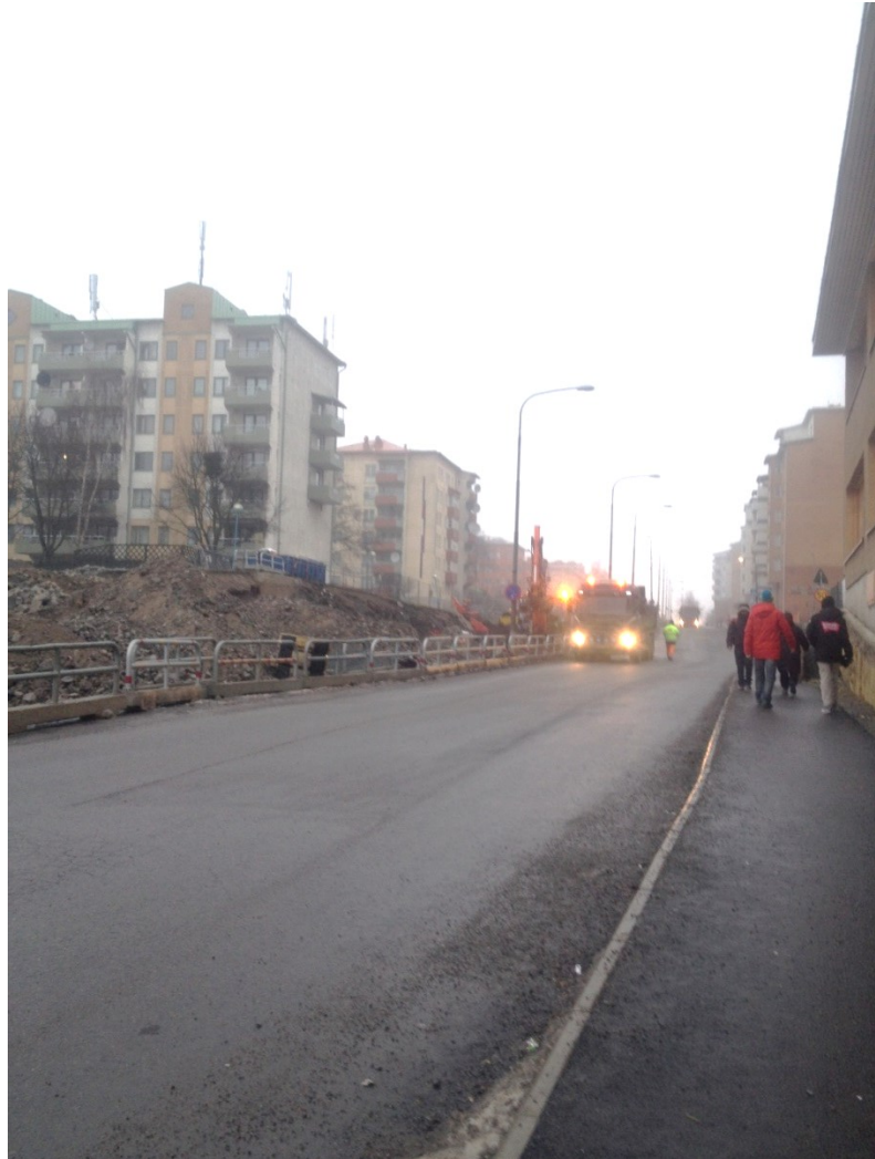
Rinkebystråket under ombyggnad i februari 2014.
