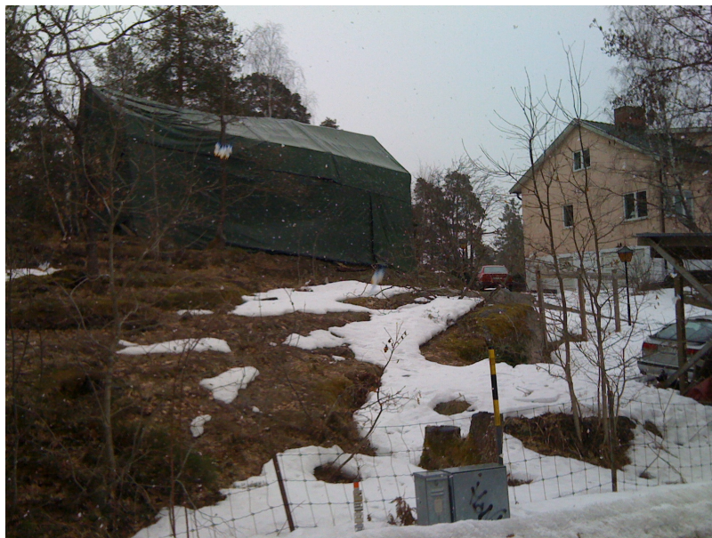
Bild tagen från gatan mot sydöst. Sluttning och huvudbyggnad syns.
