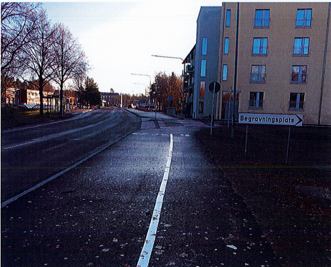
Bild 1. Den nya gc-banan längs Njupkärrsvägen samt de nybyggda bostadshusen till höger.
