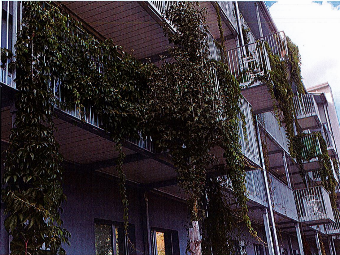
Bild 1. Grön fasad mot Njupkärrsvägen.
