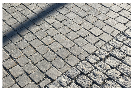
Exempel på avvikande markmaterial vid platsbildningarna.
