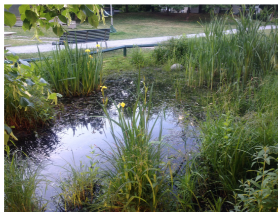
Referensbild på dike med växter som tål både torka och vatten, och samtidigt fungerar som fördröjning och rening för dagvattnet.
