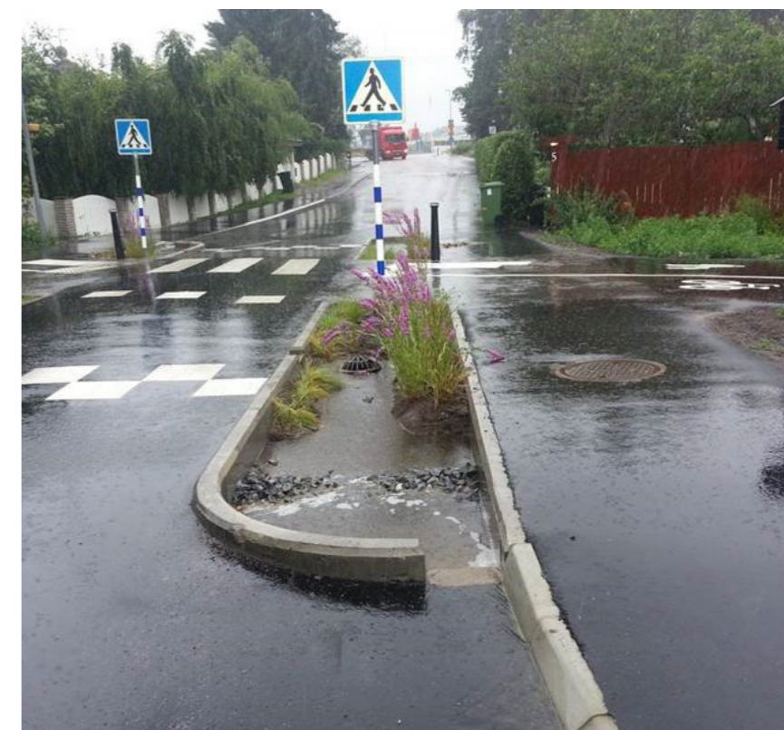
Bra exempel på välfungerande regnträdgård för lokalt omhändertagande av dagvatten i vägmiljö, Öringevägen i Tyresö.
