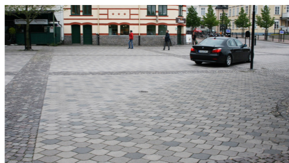
Exempel på vändplan utan kantsten med tydliga stråk i avvikande material som markerar ytor för fotgängare och plats för snöupplag.
