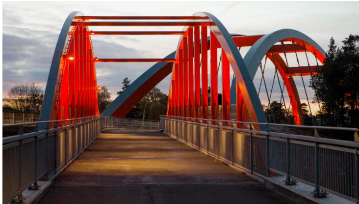
Bild 7. Den nya gc-bron över Åbyvägen med vägbron i bakgrunden
