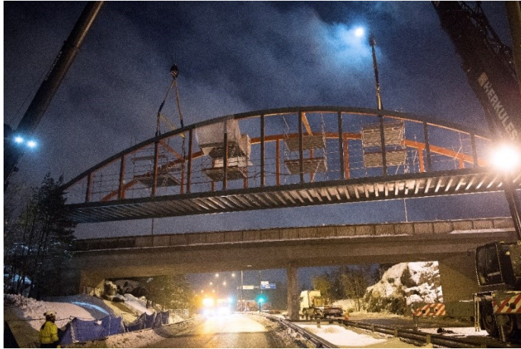
Bild 6. Gc-bron monteras. I bakgrund ser vi befintlig vägbro över Åbyvägen.
