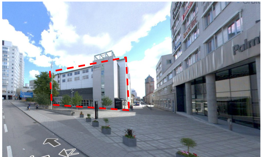
Parkeringshuset inom Sandhagen 10, bild tagen från Palmfeltsvägen, Palmfelt Center, det större kontorshuset, till höger i bild
