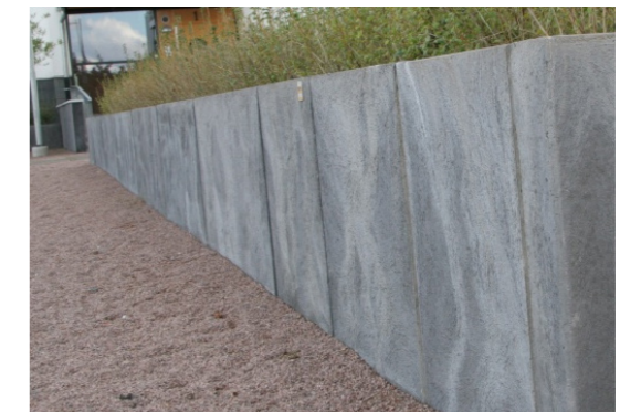
3. låg stödmur mot Bollmoravägen och i garagednfart av brädriven mörkpigmenterad betong
