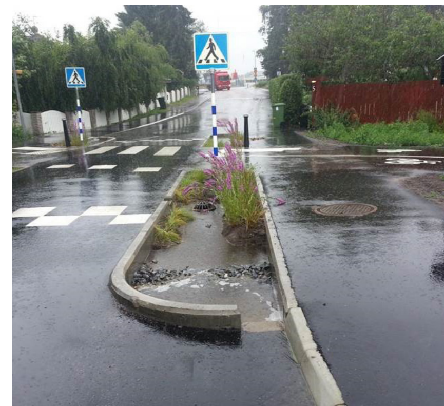
Bra exempel på välfungerade regnträdgårdar för lokalt omhändertagande av dagvatten i vägmiljö, Öringevägen i Tyresö.
