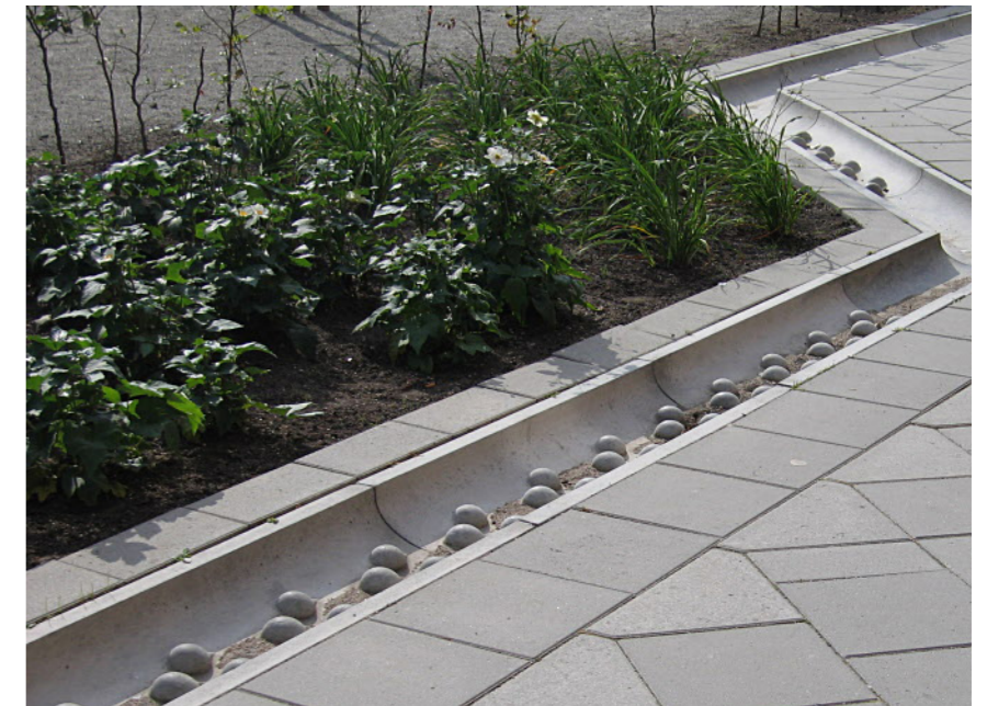
Dagvattenrännor av typ "lökrännan" utgör den öppna delen av fastighetens dagvattenlösning.
