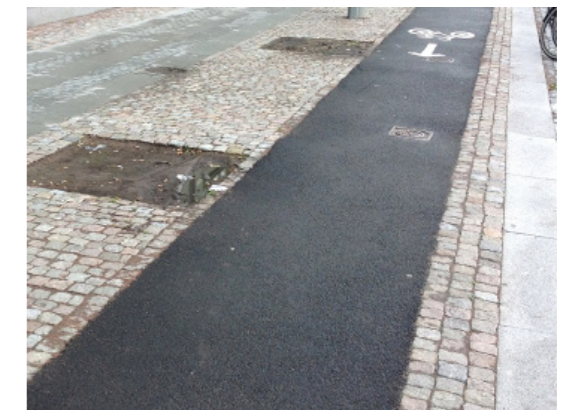
2. Asfaltspår mellan smågatsten för cykelbana
